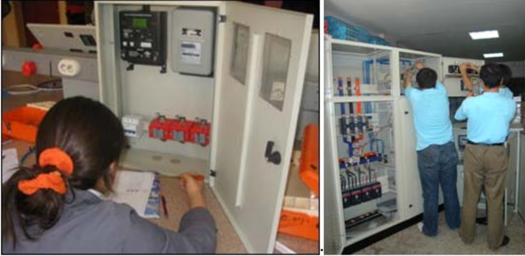
Elektrik tesisat ve pano montörlüğünün çalışma ve eğitim ortamları
